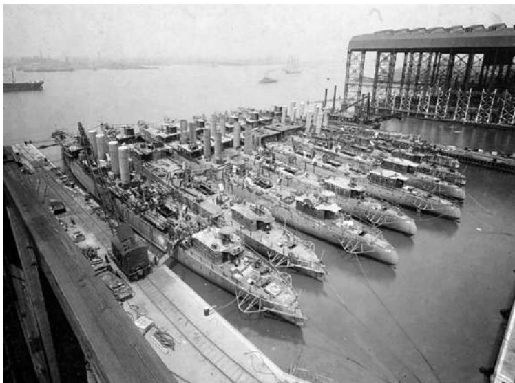
Figura 15 – Esta imagem de oito contratorpedeiros da classe Wickes, geralmente conhecidos como “the flush decker type”, em construção na New York Shipbuilding Corporation, Camden, New Jersey em 1919 ilustra a natureza de “a quantidade é uma qualidade em si própria” do programa de contratorpedeiros Norte-Americano da Primeira Guerra Mundial. Não sendo um desenho excecional, a sua disponibilidade em grandes números para conversão em escoltadores oceânicos viria a fazer deles uma arma vital na Batalha do Atlântico na Segunda Guerra Mundial
